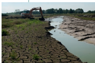
■ Travaux de curage du bief
